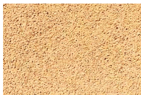
Enrobé ocre (Trottoirs)
