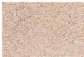
Enrobé hydrodécapé (Voirie du Parvis et carrefours)
