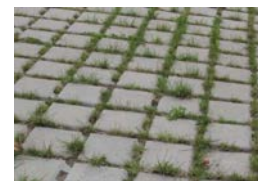
Pavés béton avec joints engazonnés (Stationnements et zones piétonnes)
