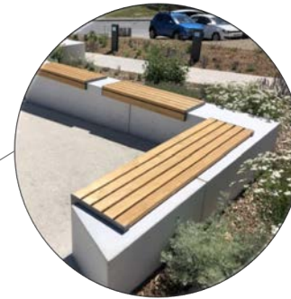
Muret en béton préfabriqué avec assises bois
