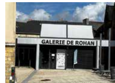
Galerie de Rohan : Pose de stores occultants sur verrière
