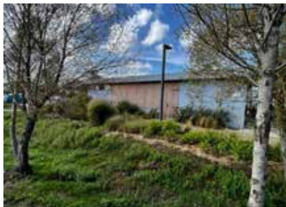
Vestiaire du parc urbain : création d'une cloison extérieure
