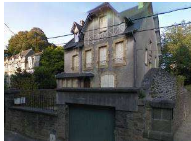
VILLA - 8, Boulevard de la Gare
