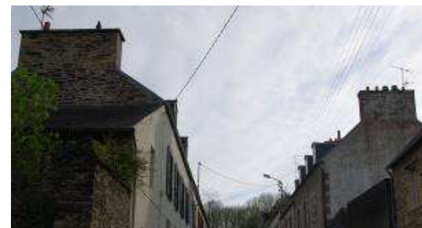
Les souches de cheminée sont positionnées en pignon. Elles sont en moellons montés au mortier de chaux.
