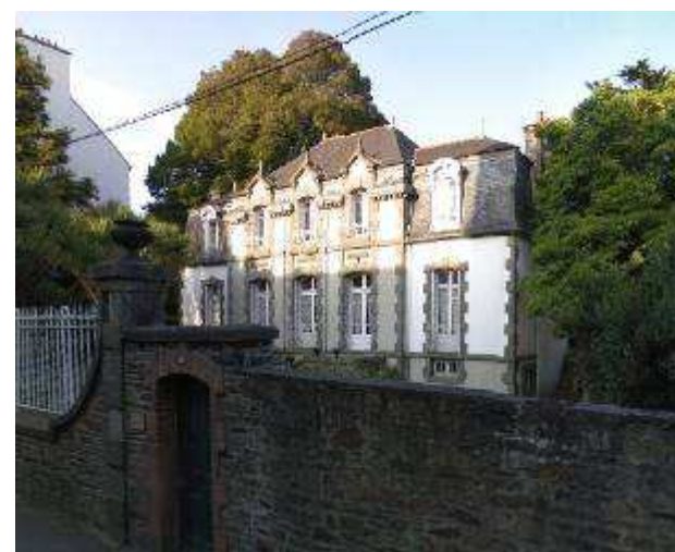
VILLA - 10, Boulevard de la Gare
