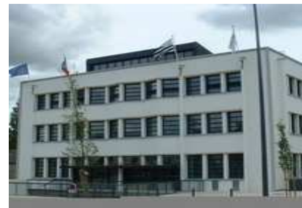
L'équilibre de la façade tient aussi au contraste entre le plein et le vide - la paroi en béton peint en blanc et les menuiseries en acier noir.
