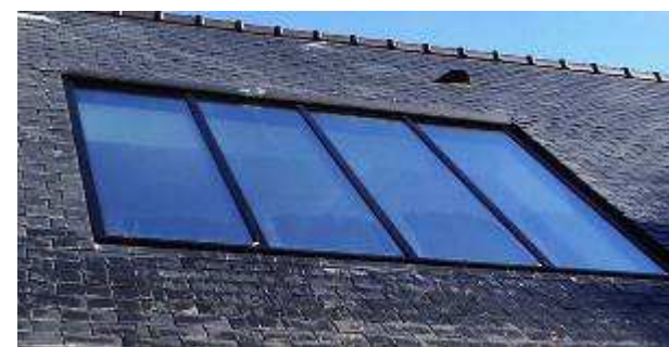
La verrière est intégrée dans le versant de la couverture
