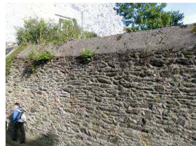
Mur de clôture en moellons assisés hourdés au mortier de chaux
